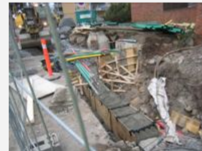
Kabelomlegging ved Silurveien
