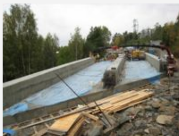
Husebybakken bru i september
